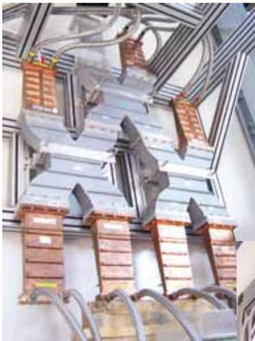
Zur Versorgung der Beschleuniger-Strukturen („Cavities“) mit der HF-Energie werden ca. 640 Koppler benötigt. Diese übertragen die 1,3 GHz mit einer Leistung von 625 kW vom Hohlleiter (Raumtemperatur ca. 20 °C) in das supraleitende „Cavity“ (1,8 K = - 271 °C).
